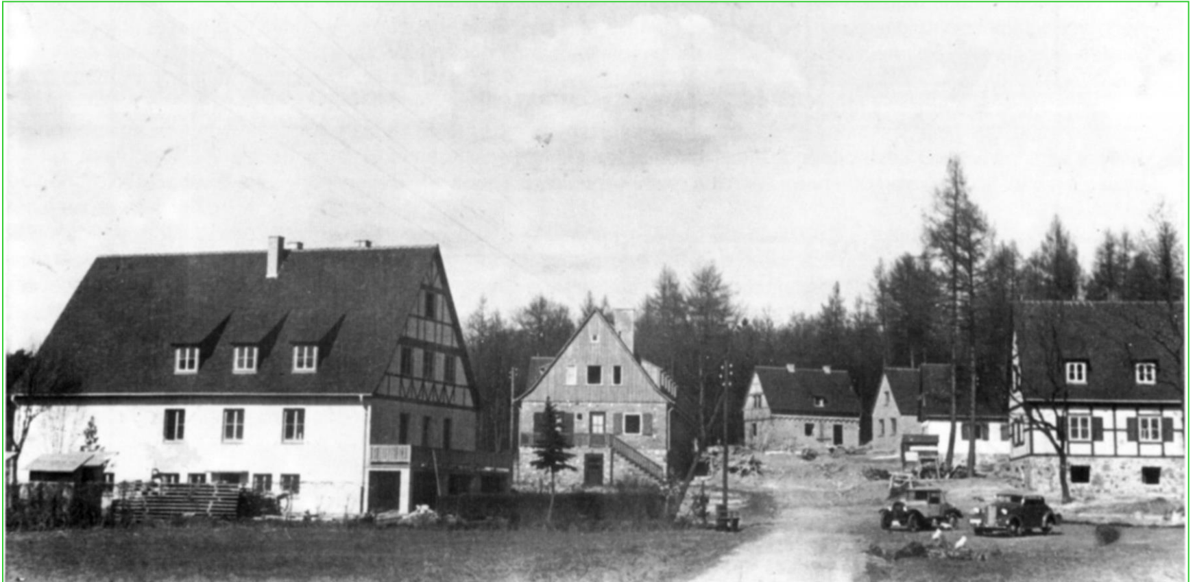
Der Kern der 1937/1938 errichteten Gausiedlungsschule
